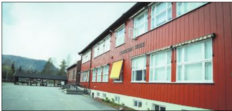
RIVES? Lampeland skole blir stående ubrukt når den nye skolen står klar høsten 2019. Nå er det uenighet om når bygget bør rives.
